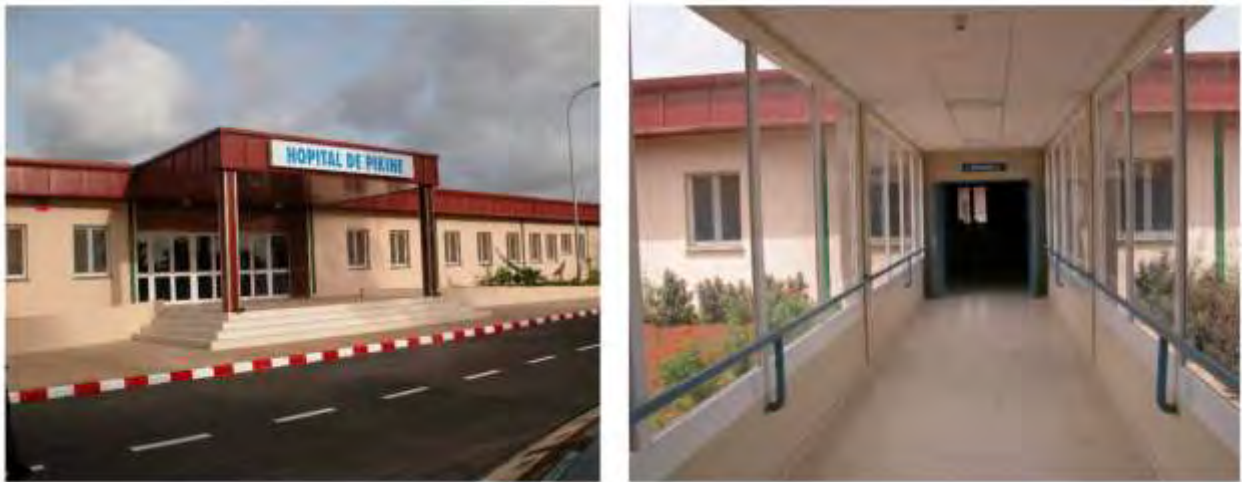
Figure 8. Centre Hospitalier National de Pikine (Image Google, Août 2020)
